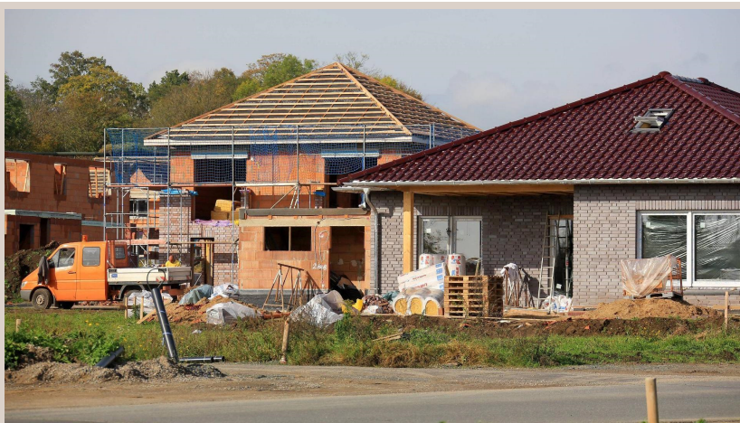
Etwa ein Drittel aller privater Neubauten, werden durch einen Bauträger errichtet. (Quelle: Rust/Imago)
